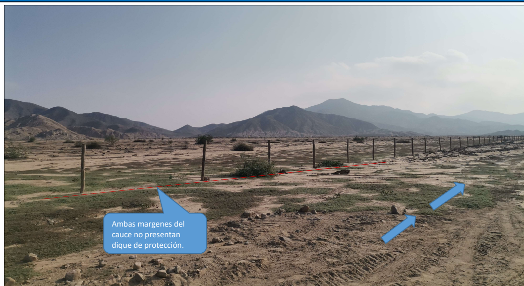
FIGURA N°01: QUEBRADA HUEREQUEQUE SIN PRESENCIA DE DIQUE DE PROTECCIÓN EN EL SECTOR HUAYAN, POR LO QUE SE ENCUENTRA ANTE EL RIESGO DE DESBORDE AFECTANDO A LOS CAMPOS ALEDAÑOS.
